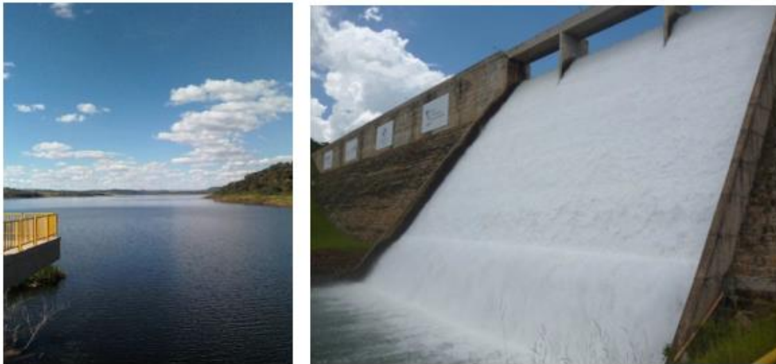
Figura 2. Reservatório do Ribeirão João Leite (à direita, detalhe vertedor)
